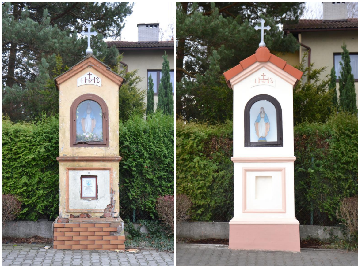
Kapliczka przed i po renowacji.
