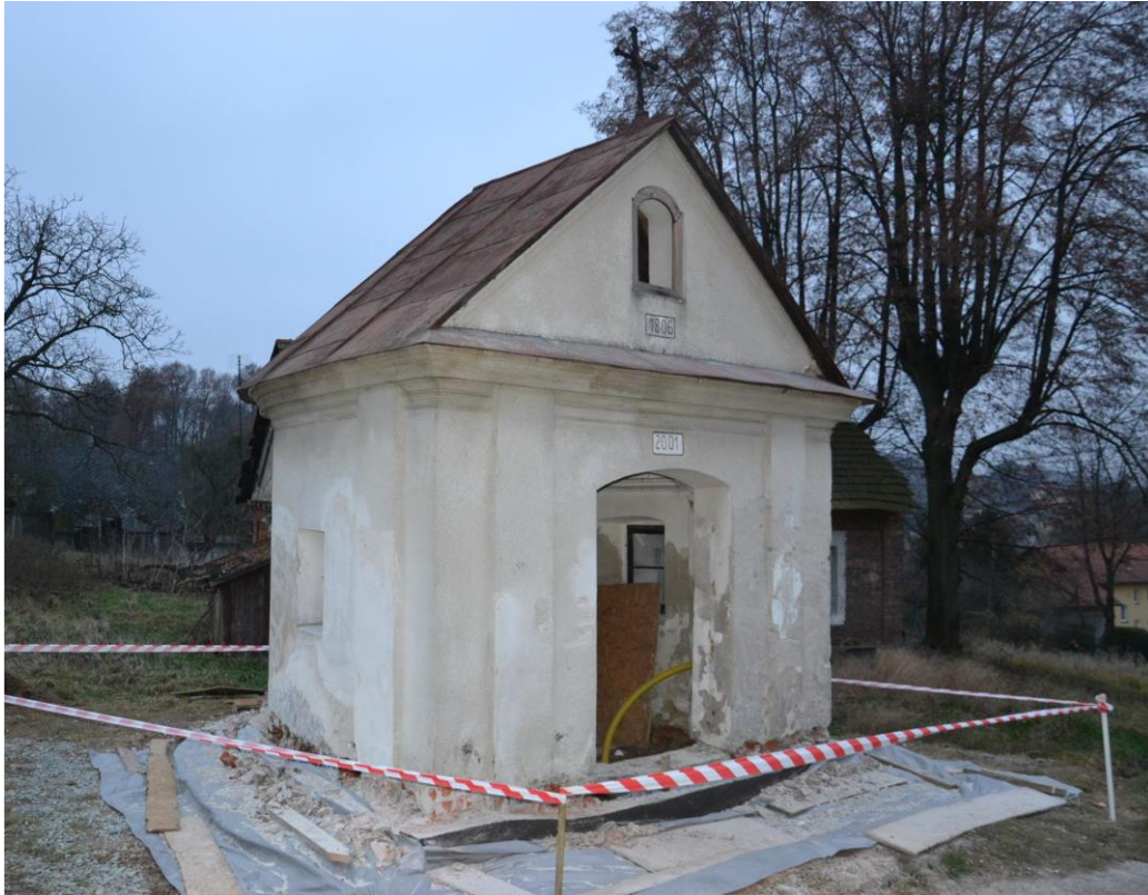
Zakończenie prac polegających na wzmocnieniu fundamentu oraz ułożeniu drenażu opaskowego.
